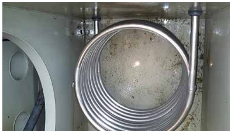
Het verwarmde water loopt door een spiraal.
